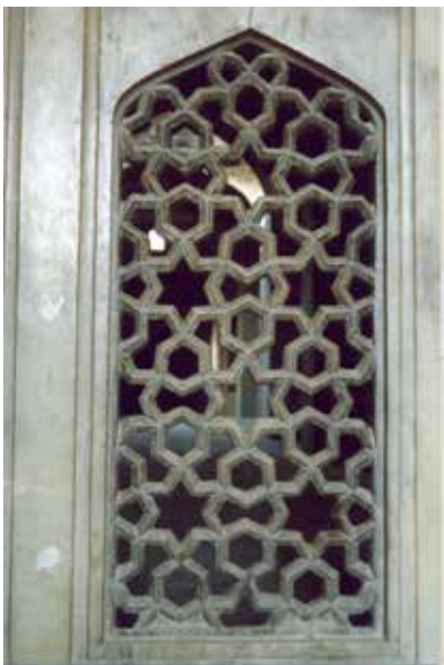
تصویر شماره ۱۶: پنجره بی‌همتای مشبک و یک پارچه «سنگ آذری» از نقوش هندسه گره «هشت‌تبل» صفا درویش، مسجد جامع اصفهان (دوره صفویه)
