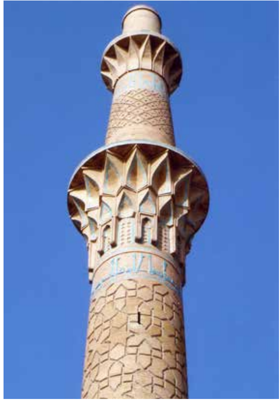
تصویر شماره ۶: با ارزش‌ترین هنر آجر کاری از نقوش، مأذنه‌سازی از پدیده هنر «رسمی و قطار» با کاربرد کاشی از هنر گره، معقلی و خط، میل ساربان؛ اصفهان (دوره سلجوقی، بازسازی معاصر)
