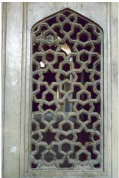
تصویر شماره ۱۶: پنجره بی‌همتای مشبک و یک پارچه «سنگ آذری» از نقوش هندسه گره «هشت‌طبل» صدف درویش، مسجد جامع اصفهان (دوره صفویه)
