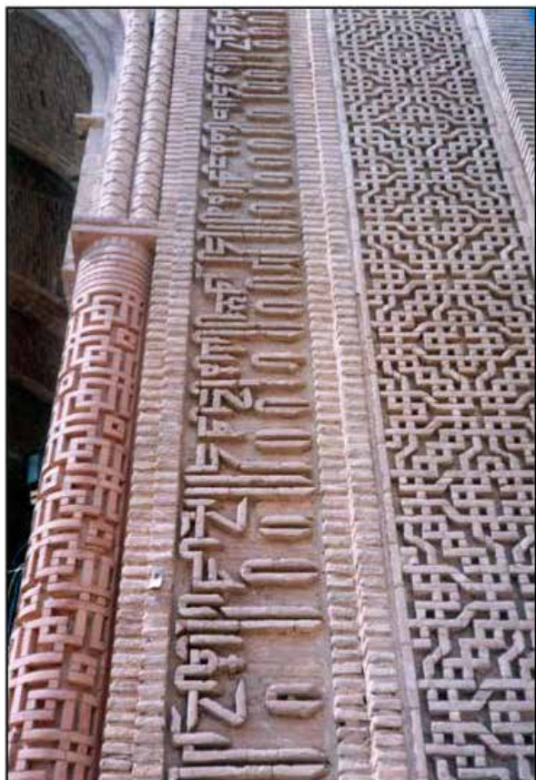
تصویر شماره ۹: جزئیات اجرایی بسیار هنرمندانه شامل ۱- فتیله فلکه نبش ایوان از نقش گود و برجسته «پیلی گردان» ۲- خط کوفی آجری گود و برجسته «سوره مبارکه جمعه» ۳- نقوش گود و برجسته «بازوبندی و بند رومی» بازسازی معاصر اثر معمار بزرگ ایران «زنده یاد استاد حسین نقوایی» از تصویر قبل
