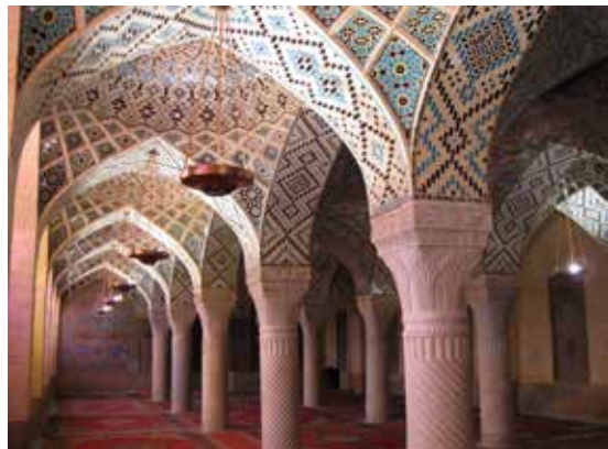
تصویر شماره ۲۱: ستون‌های پیچ تراش سنگ «بوت‌ه جقه‌ای» تاق‌پوش‌های «پاتوپا» «رسمی» و نقوش شگرف معقلی از «گره طبل و ... و خورشیدی منقوش معقلی و ...» شبستان مسجد بی‌نظیر حاج حسین نصیرالملک، شیراز (دوره قاجاریه)
