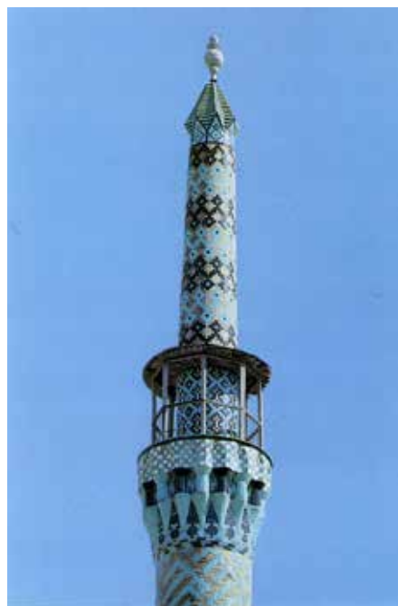
تصویر شماره ۱۷: یکی از دو گلدسته اصطلاحاً «شاخ شمشاد» بسیار بی‌مانند از مآذنه‌سازی با انواع طرح خوشه انگوری - رو، وارو و ... گلچین‌ها از کاشی معرق با قبه ترکیب الماس تراش، مسجد کبیر یزد (دوره صفویه - اسکلت مسجد از دوره آل مظفر)
