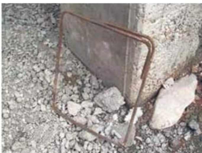
تصویر ۷- نمونه‌ی یک خاموت
