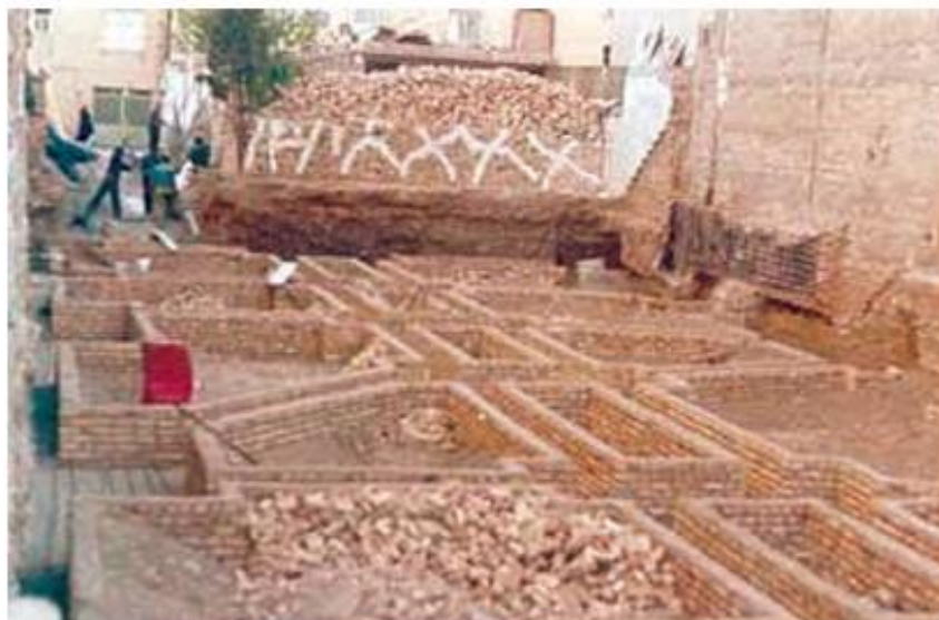
تصویر ۵ - قالب‌بندی آجری پی ساختمان
