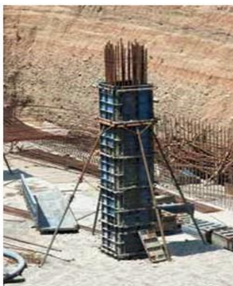
تصویر ۴ - قالب بندی فلزی ستون
