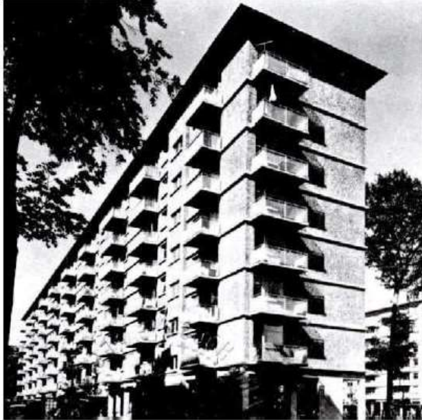
سیستم کاموس یک بلوک ساختمانی از برنامه ۴۰۰۰ واحدی دولت فرانسه در سال ۱۹۵۴
