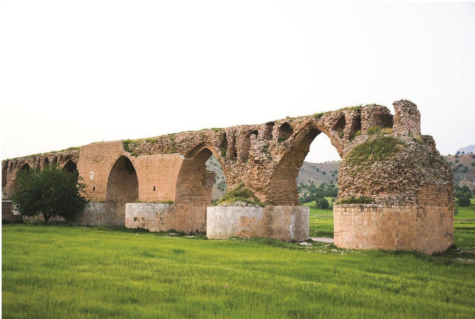
پل کشکان واقع در ۵۲ کیلومتری خرم آباد راه ارتباطی همدان به شوش (دوره ساسانی)
