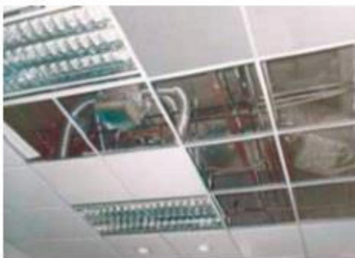
تصویر ۲۰ - زیر سازی سقف کاذب
