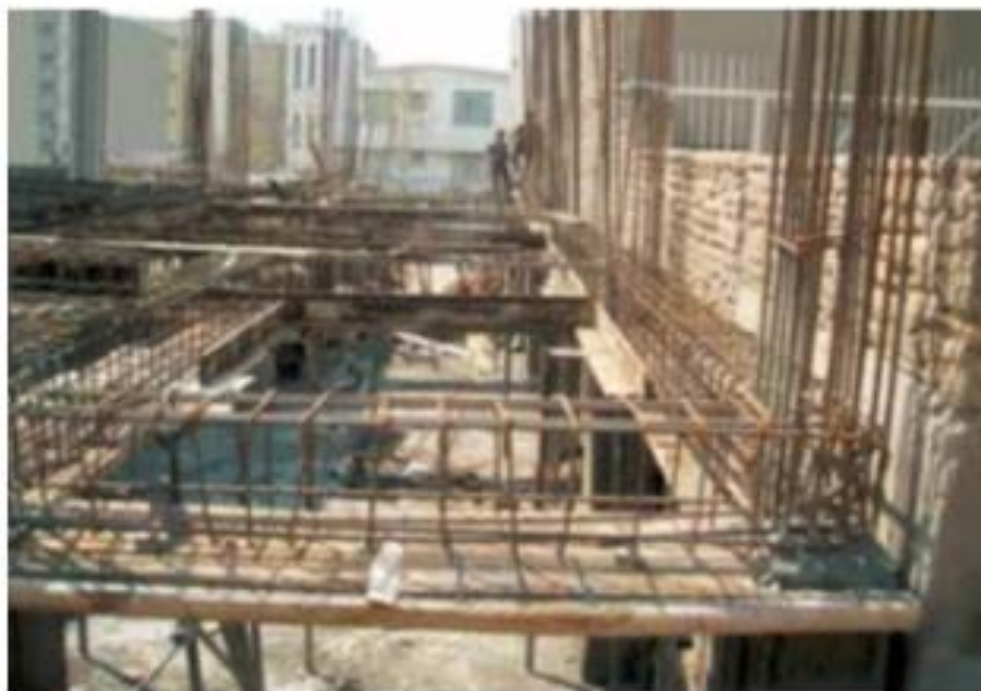
تصویر ۱۲ - نحوه فرارگیری آرماتورهای کلاف‌های بتنی
