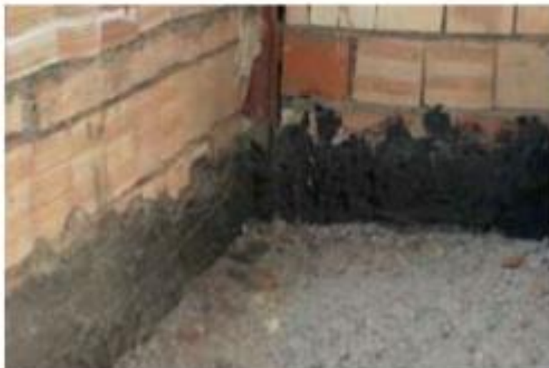
تصویر ۱۶ - عایق کاری کف سرویس بهداشتی
