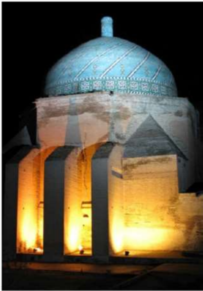
پشت بندهای گنبدخانه مسجد جامع قزوین
