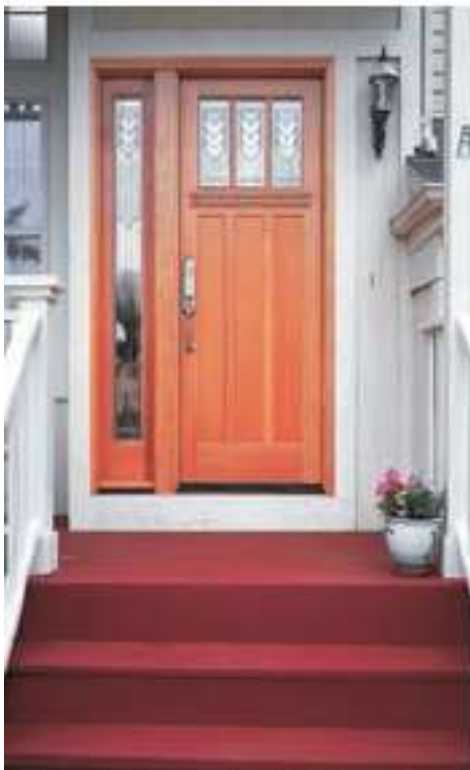
تصویر ۲۷-۲-الف- نمای ورودی از بیرون بنا
