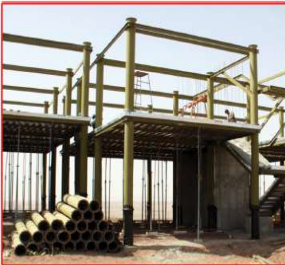
سازه‌های فولادی بتنی Composit Steel Concrete Structure
