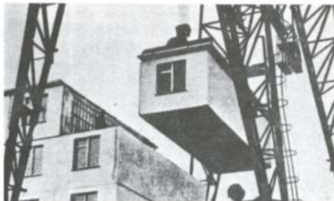
سیستم سلولی - ساختمان سنگین منازل فارکوف در شوروی سابق
